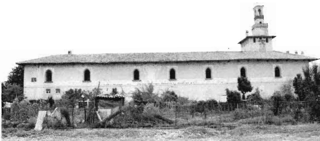
9. Castello di Cusago, corpo sud fronte esterno.
