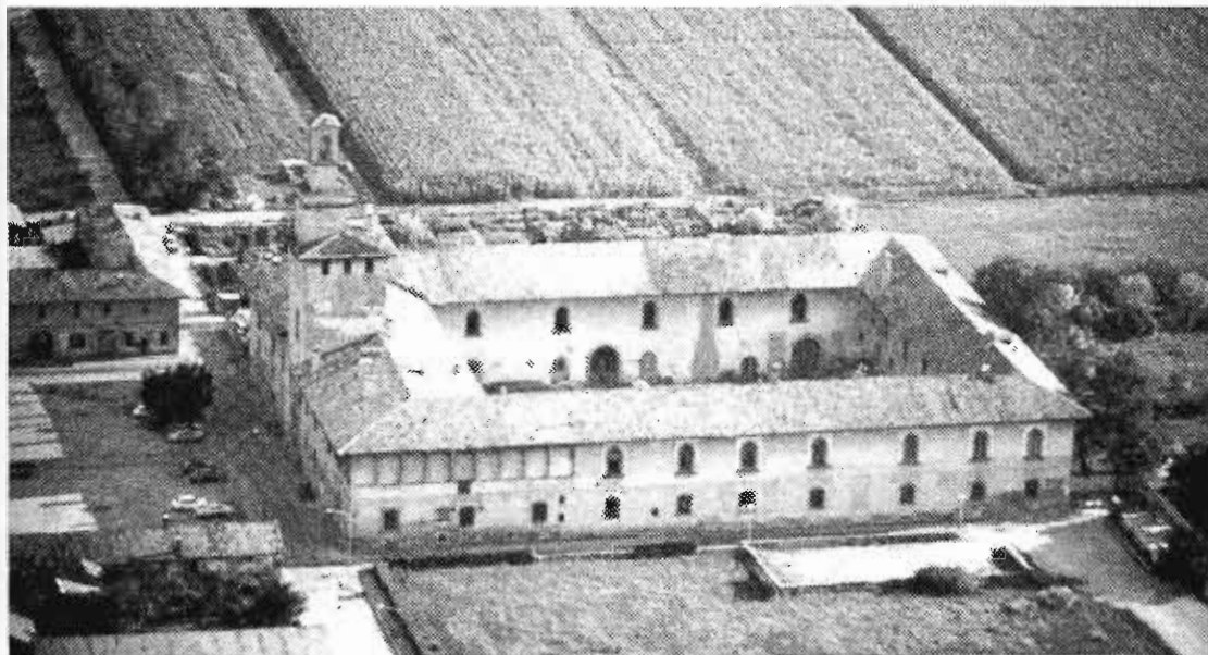
1. Cusago, veduta aerea del castello.
