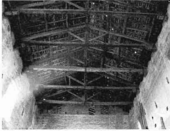
12. La copertura del salone.
